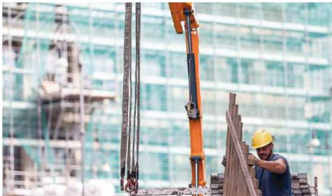
Un cantiere avviato con i fondi del Superbonus al 110 per cento
